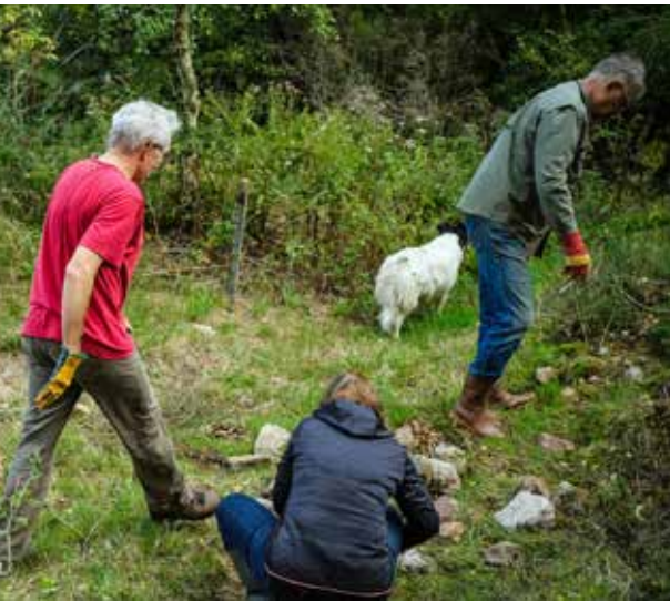
Chantier participatif de bénévoles à la ferme du Brezouard en Alsace.
